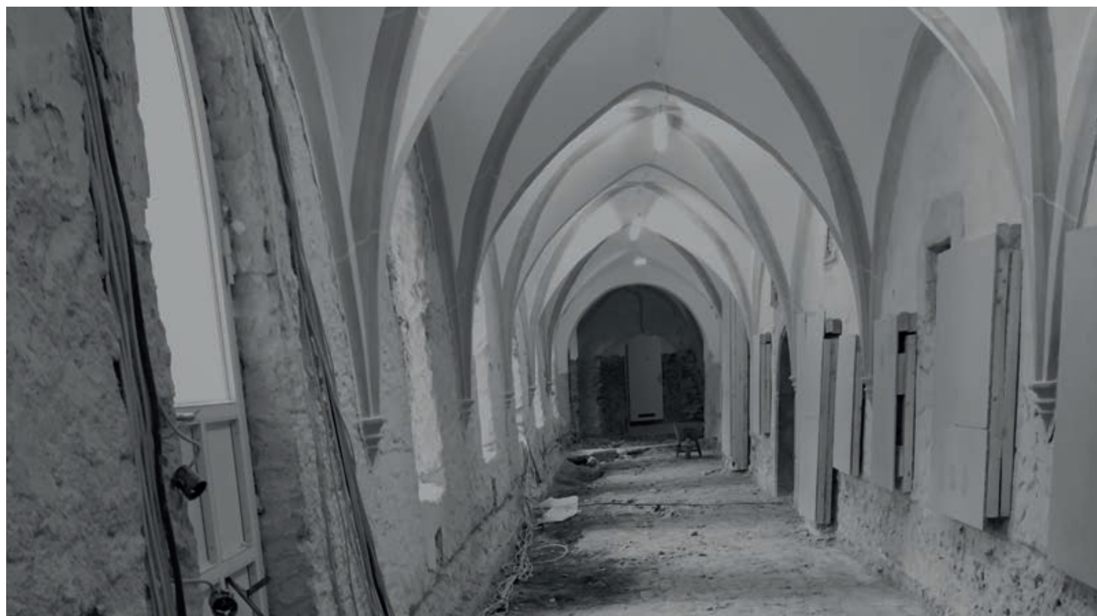
VORHER Kreuzgang nach Abtragung der Boden- und Putzschichten
